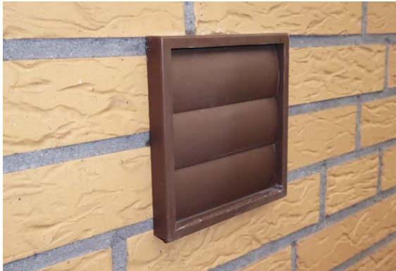
Bild 6: Günstige Entlüftungslösung – ein Abluftventilator in der Außenmauer
