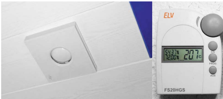
Bild 5: Für jede Dusche empfehlenswert: automatisch gesteuerte Entlüftungsanlage
